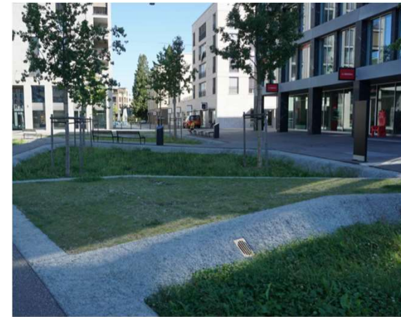
Wasser für Pflanzen verfügbar machen Retentionsmulde in Aarau
